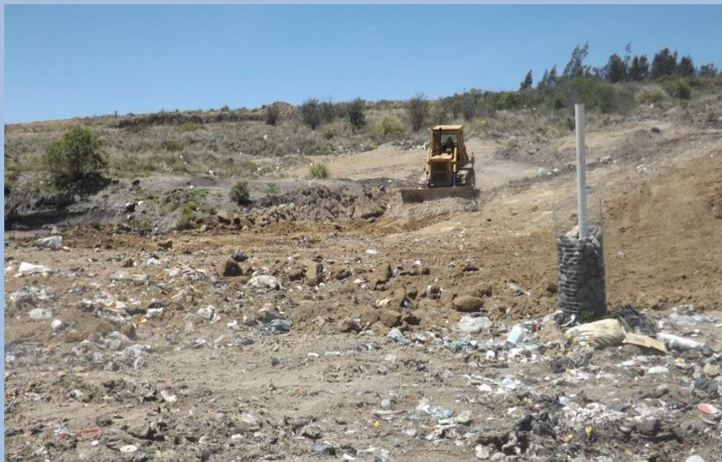
Trabajos de compactación y cobertura de los residuos sólidos Fecha: 18 de Noviembre del 2016 (Segunda Plataforma)
