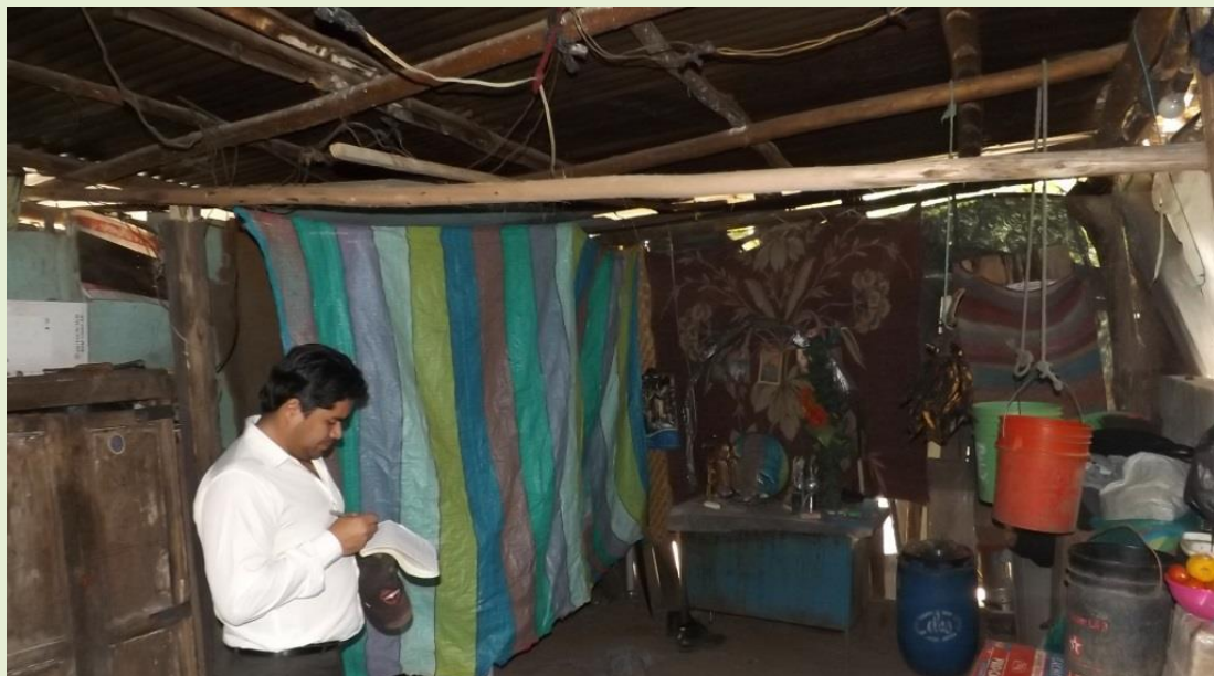
Paredes conformadas con cobijas y plásticos.
