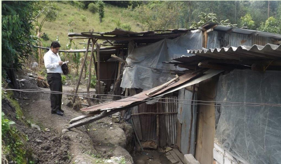
Paredes conformadas con cobijas y plásticos.
