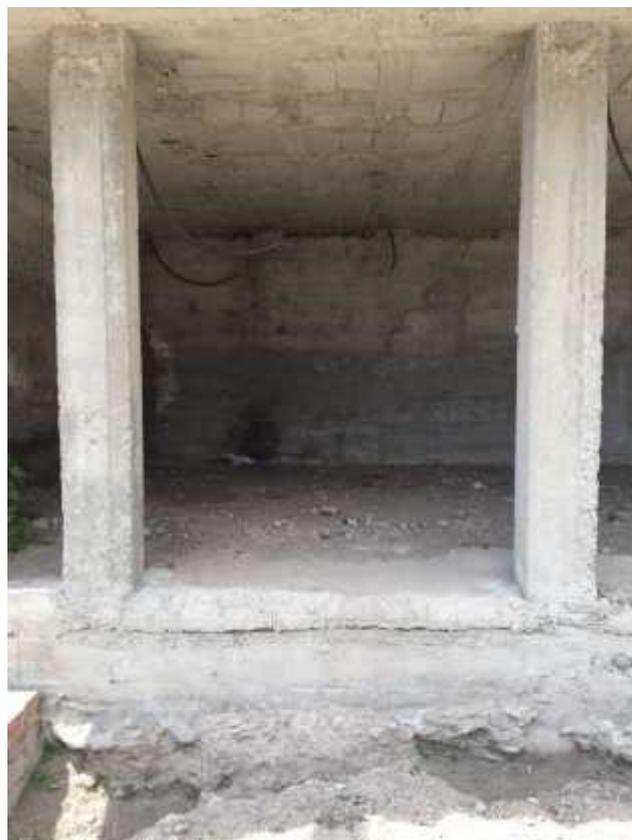
En la actualidad tenemos la presencia del Centro de Participación Ciudadana el cual está implantado en sentido este-oeste y en la parte posterior existe un espacio ya que tenemos un desnivel de 3m aproximadamente y esta sostenido por una estructura conformada por columnas y losa, además del contrapiso.
