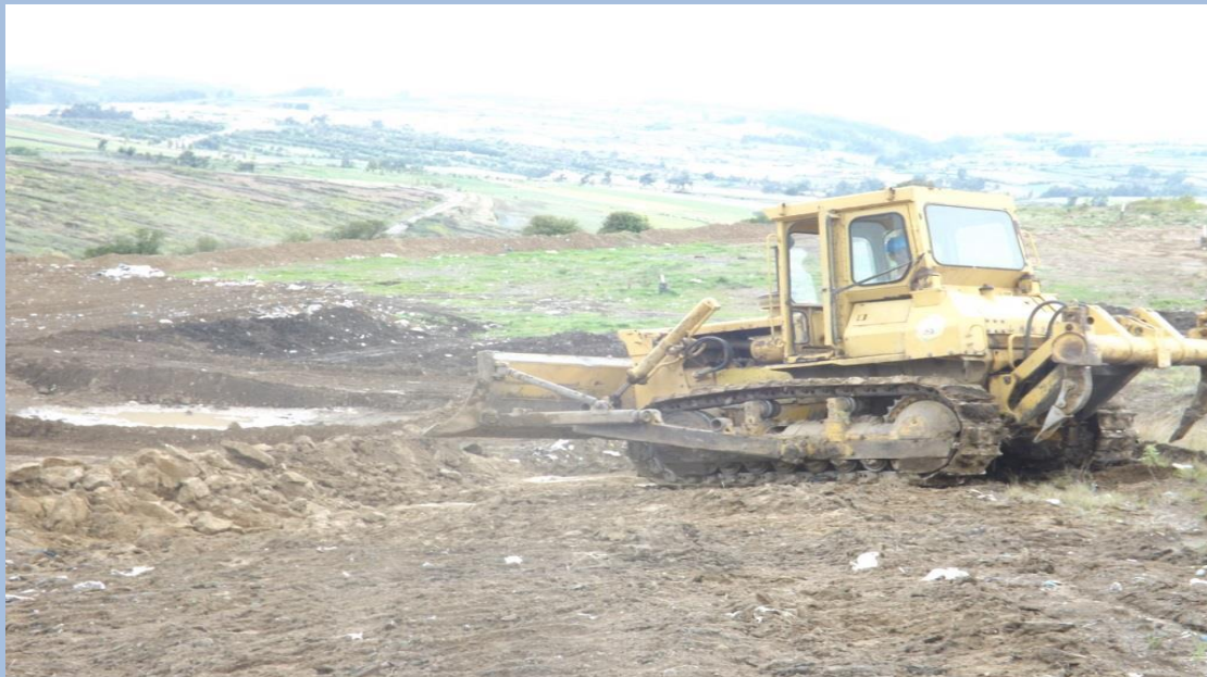
Trabajos de cobertura de los residuos sólidos Fecha: 14 de Noviembre del 2019 (Segunda Plataforma)
