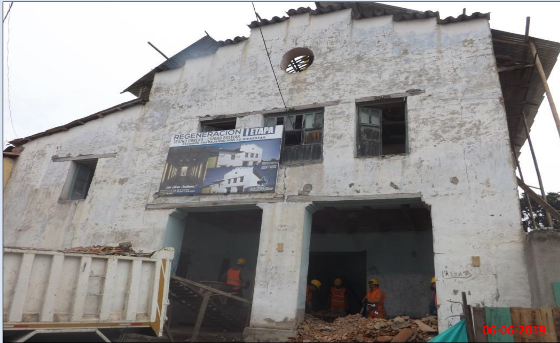
Desalojo de escombros al final de cada jornada de trabajo Fecha: 06 de Junio del 2019
