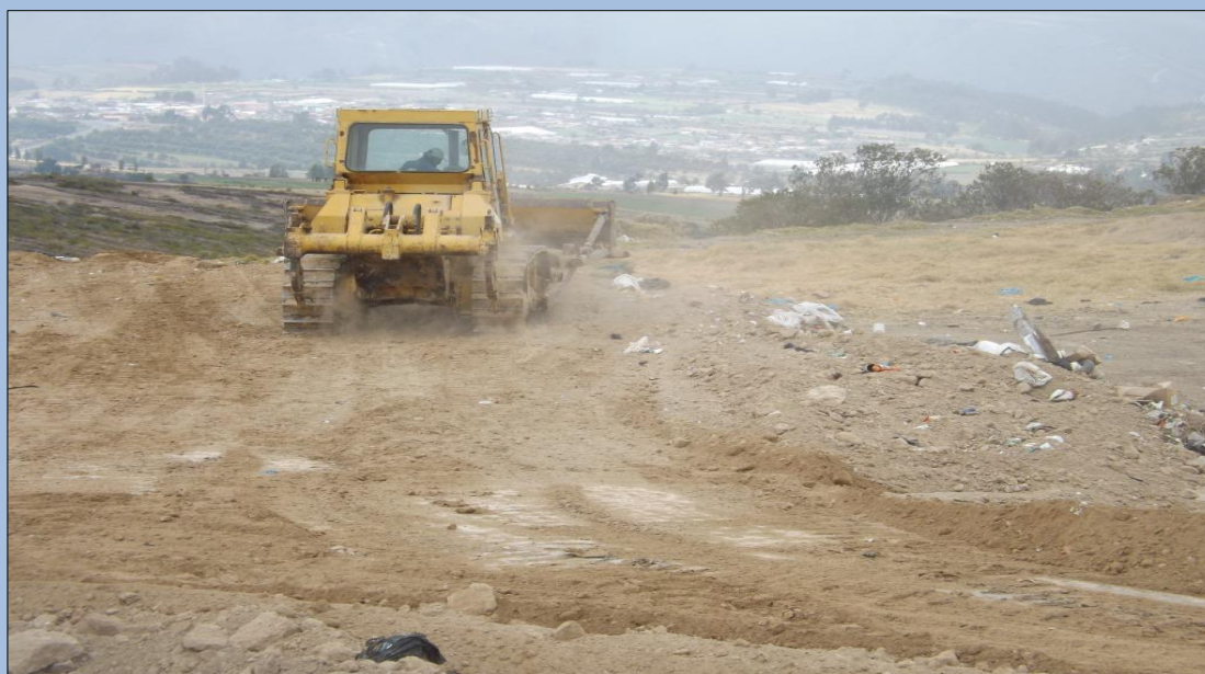
Trabajos de cobertura de los residuos sólidos Fecha: 14 de Agosto del 2019 (Segunda Plataforma)
