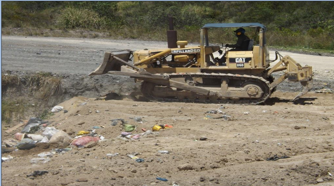
Trabajos de cobertura de los residuos sólidos Fecha: 16 de Enero del 2020 (Segunda Plataforma)
