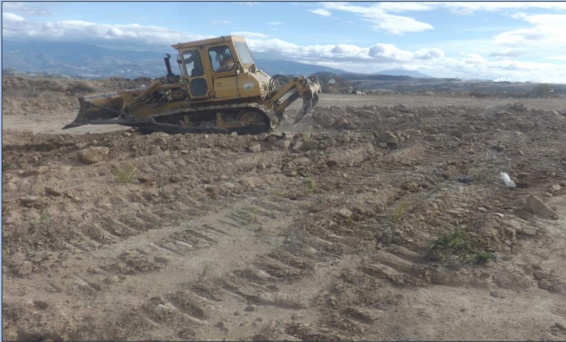
Acopio de material de cobertura de los residuos sólidos Fecha: 21 de Octubre del 2020 (Segunda Plataforma)
