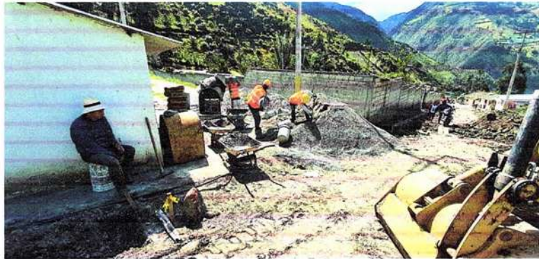
- Fotografía 3.- Zona de recepción de material libre de escombros.
