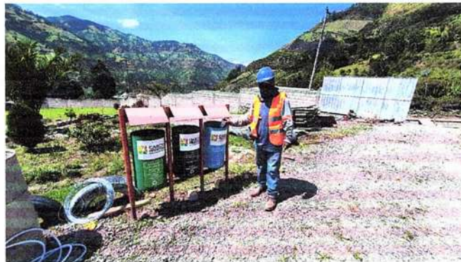
- Fotografía 10.- Se realizó la disposición adecuada de los desechos y residuos sólidos en los depósitos existentes en el lugar de la obra.
