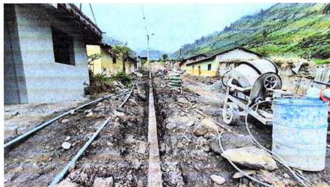
- Fotografía 5.- Trabajo diurno con maquinaria para optimizar el trabajo
