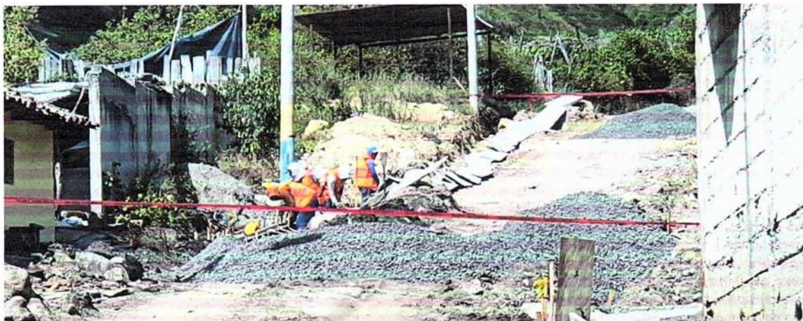
- Fotografía 11.- Se utiliza cinta de seguridad para impedir la circulación vehicular.
