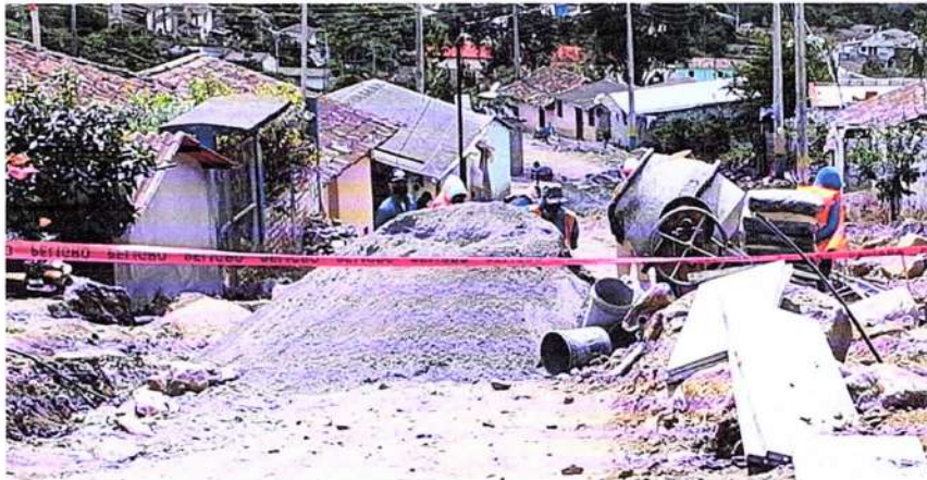
- Fotografía 1.- Material pétreo en obra.
