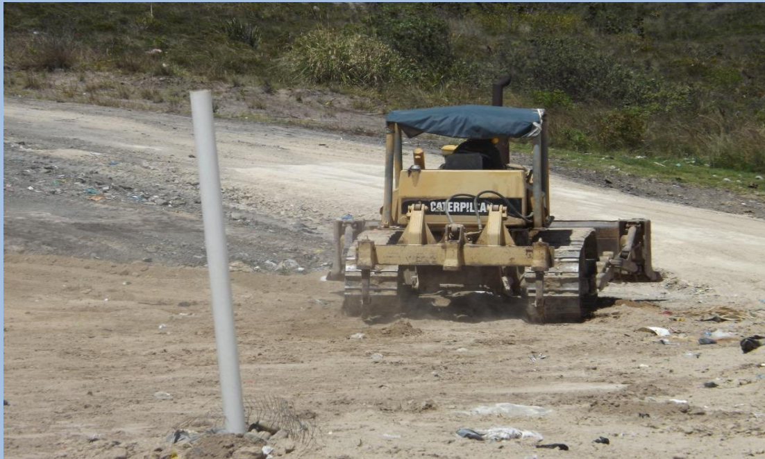
Trabajos de cobertura de los residuos sólidos Fecha: 19 de Febrero del 2020 (Segunda Plataforma)
