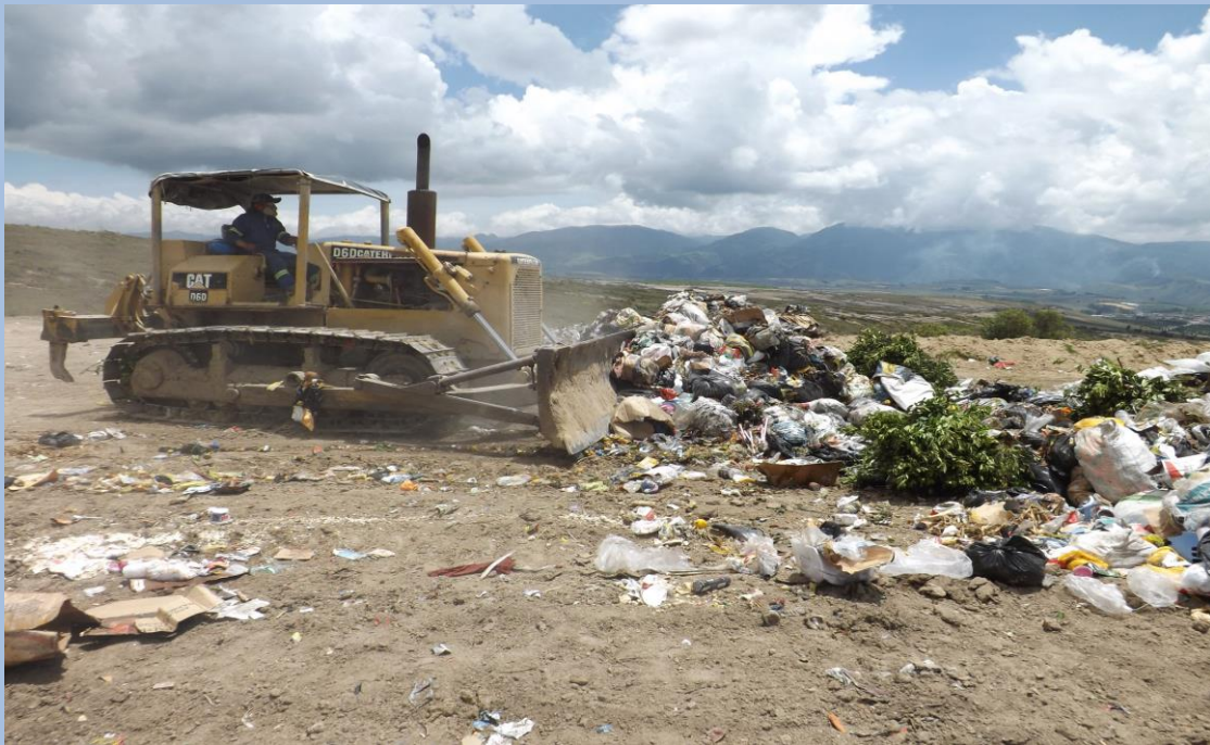
Trabajos de cobertura de los residuos sólidos Fecha: 10 de Septiembre del 2020 (Segunda Plataforma)
