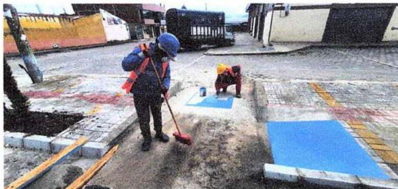
**- Fotografía 5.- Se protegen las superficies a ser pintadas; Se realiza este trabajo al aire libre; todos los obreros utilizan mascarillas para ejecutar el trabajo (2021-2-14)**
