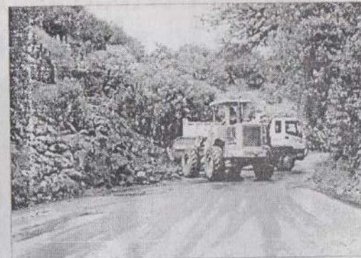
La maquinaria de Bolívar en mantenimiento de la vía Caldera - San
