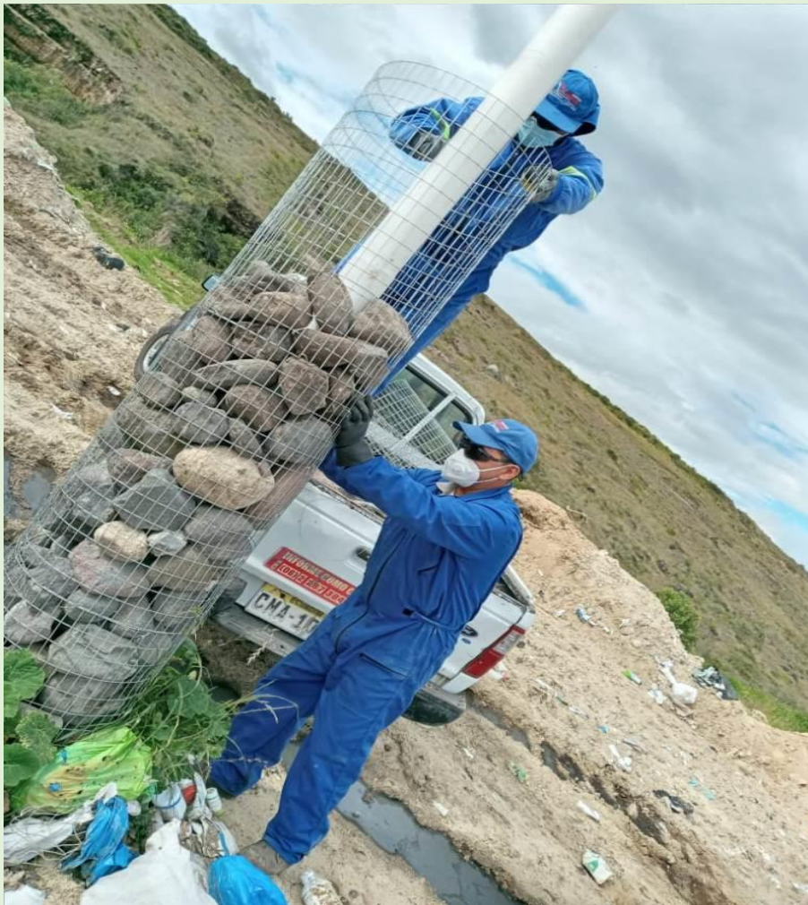
Construcción de Chimeneas de biogás Segunda Plataforma Fecha: 19 de Mayo del 2021
