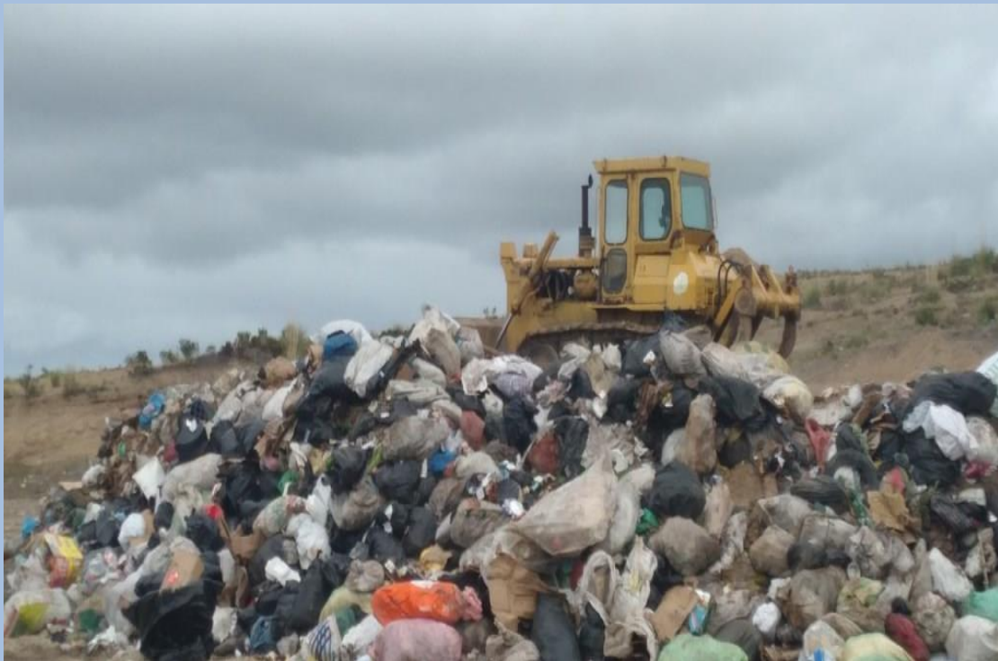
Trabajos de empuje, compactación y cobertura de los residuos sólidos Fecha: 16 de Junio del 2021 (Segunda Plataforma)
