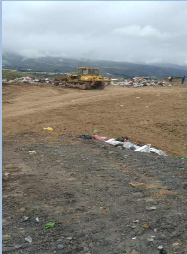
Trabajos de empuje, compactación y cobertura de los residuos sólidos Fecha: 15 de Julio del 2021 (Segunda Plataforma)
