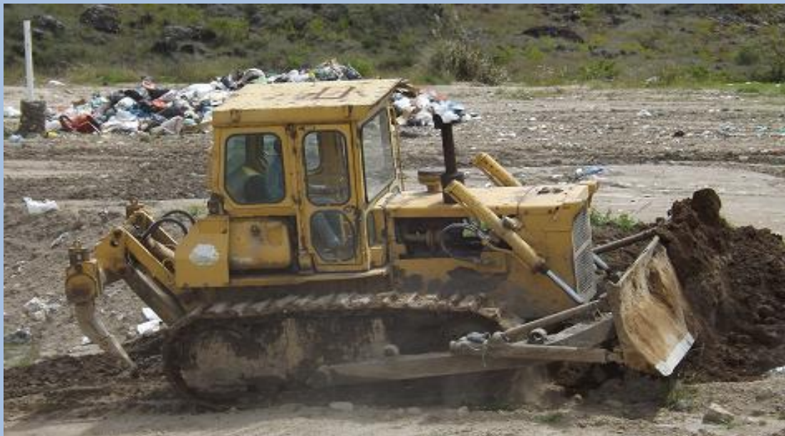
Trabajos de empuje, compactación y cobertura de los residuos sólidos Fecha: 13 de Agosto del 2021 (Segunda Plataforma)
