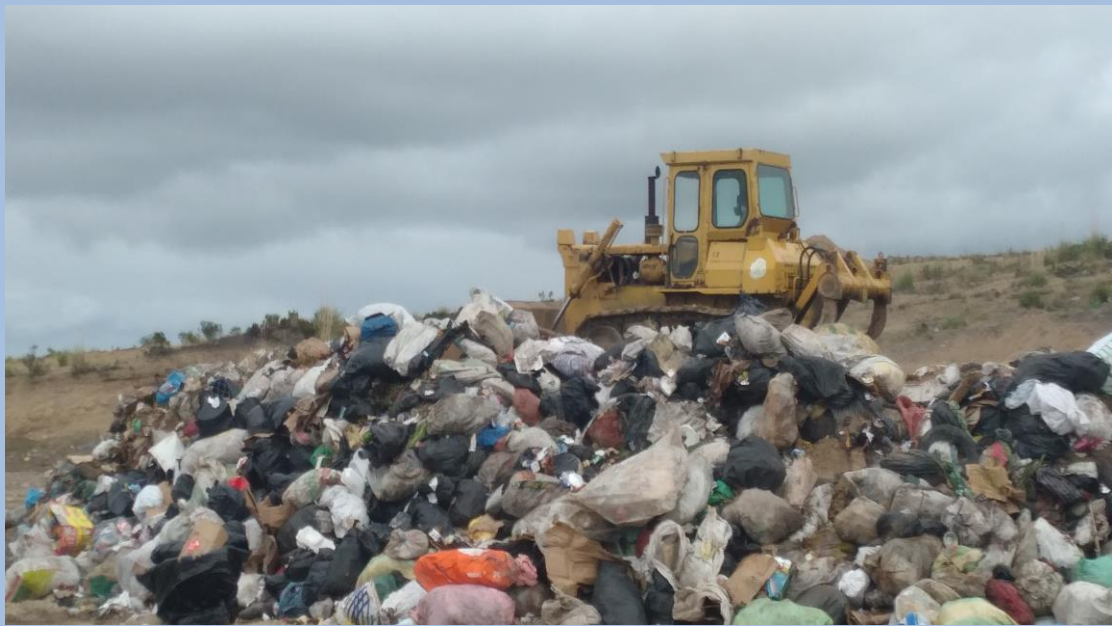
Trabajos de empuje, compactación y cobertura de los residuos sólidos Fecha: 14 de Octubre del 2021 (Segunda Plataforma)
