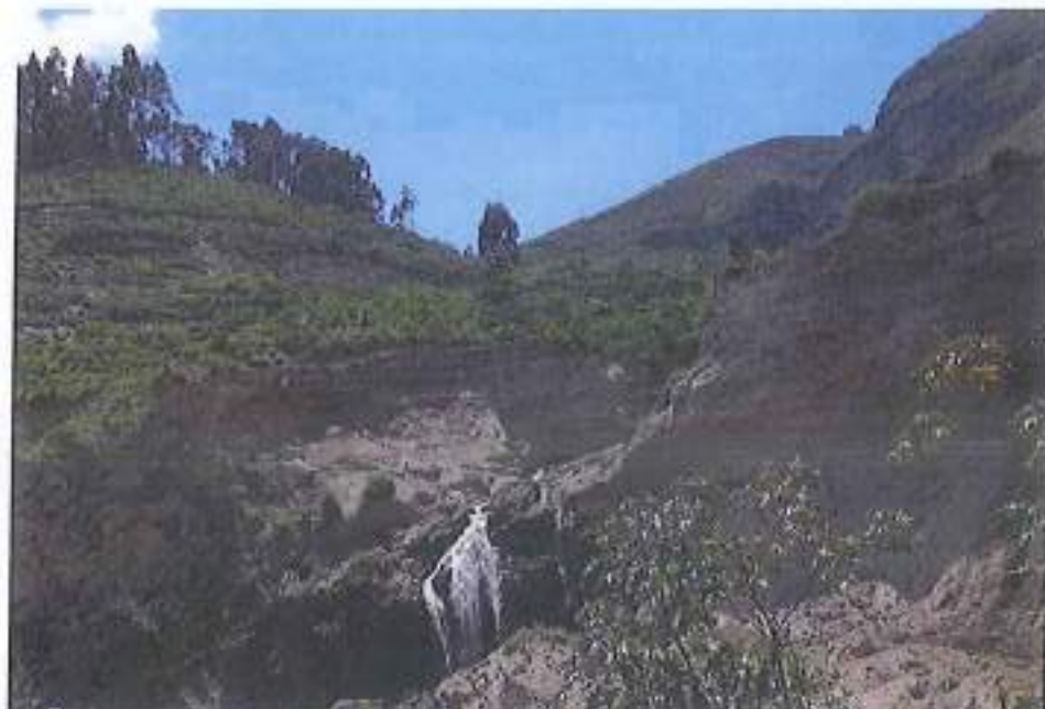
Foto 1. Área afectada por el deslizamiento
