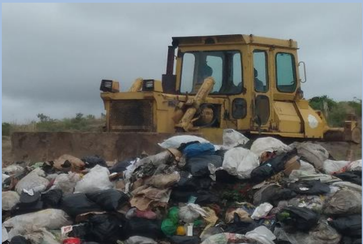
Trabajos de empuje, compactación y cobertura de los residuos sólidos Fecha: 15 de Diciembre del 2021 (Segunda Plataforma)
