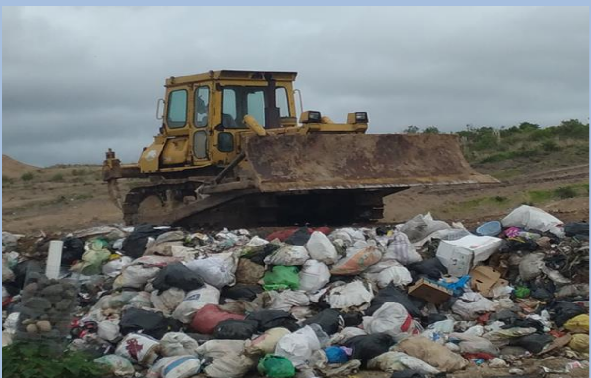
Trabajos de empuje, compactación y cobertura de los residuos sólidos Fecha: 06 de Enero del 2022 (Segunda Plataforma)
