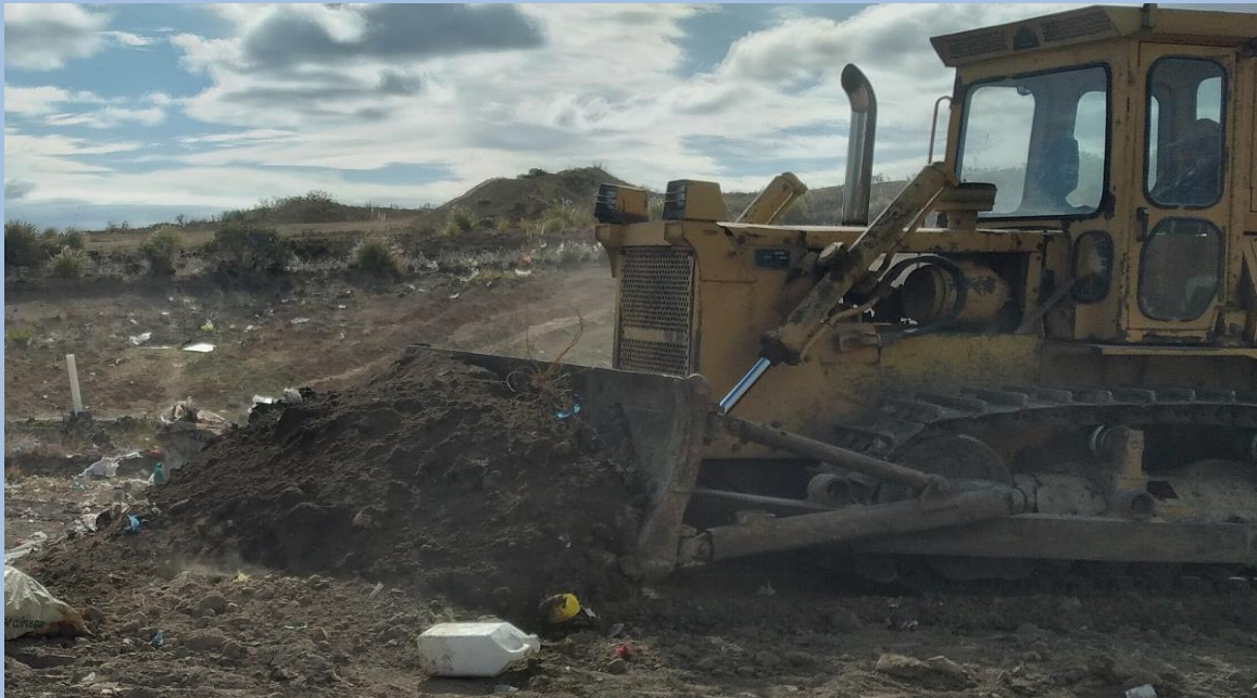
Trabajos de empuje, compactación y cobertura de los desechos sólidos Fecha: 09 de Febrero del 2022 (Segunda Plataforma)
