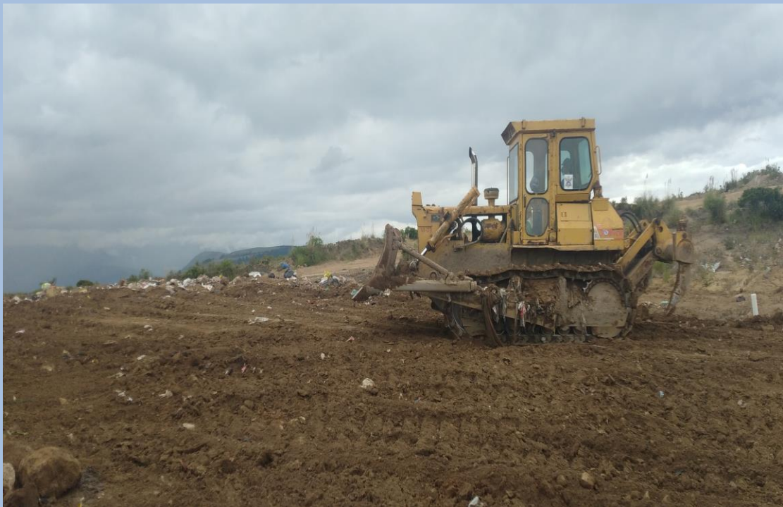
Trabajos de empuje, compactación y cobertura de los desechos sólidos Fecha: 11 de Mayo del 2022 (Segunda Plataforma)
