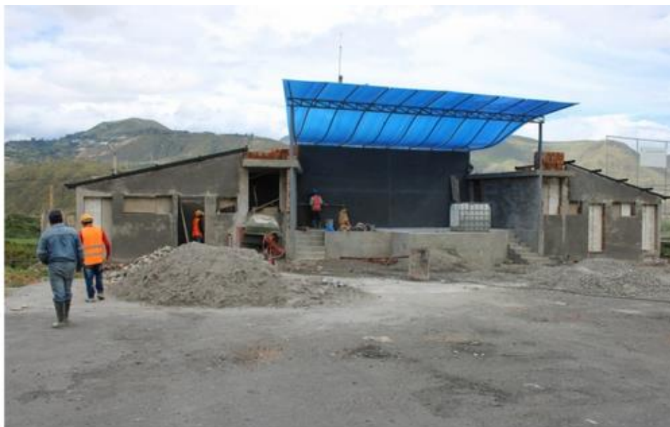
Obras en el cantón Bolívar.
