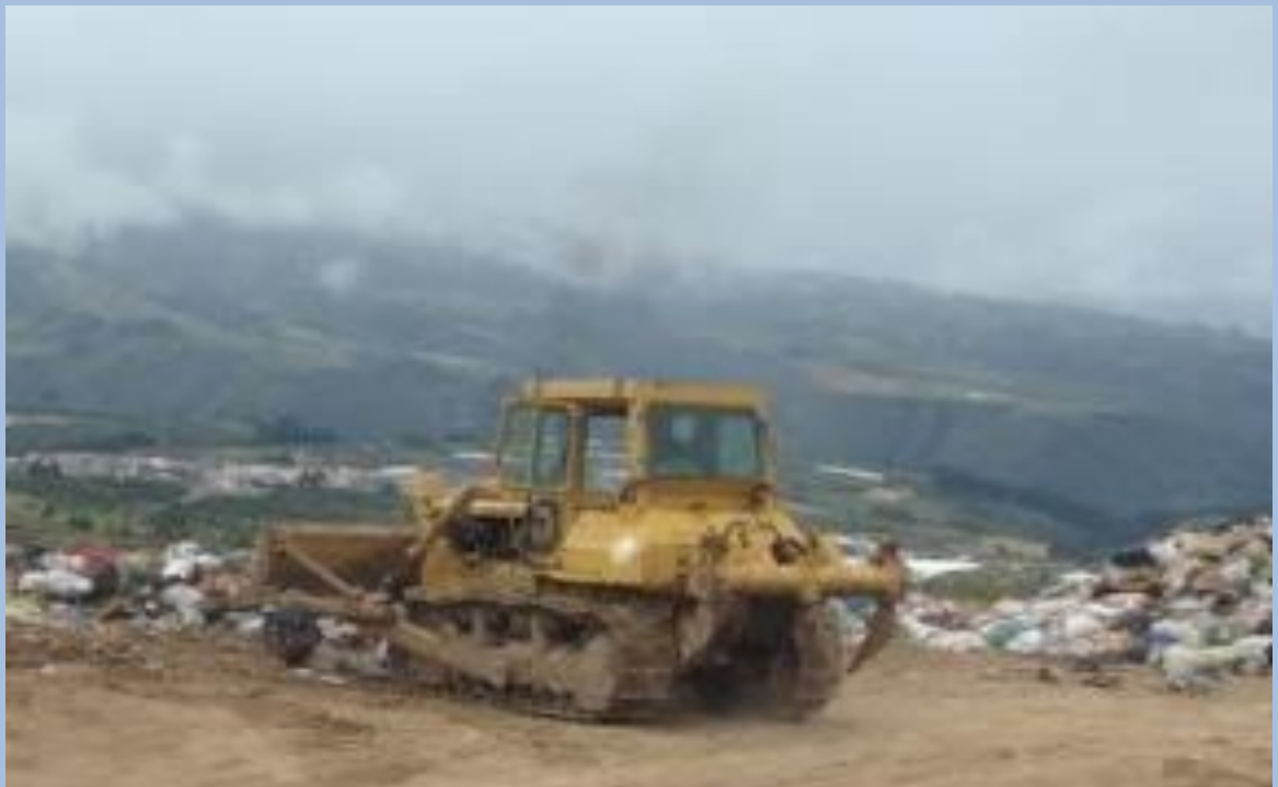
Trabajos de empuje, compactación y cobertura de los desechos sólidos Fecha: 15 de Junio del 2022 (Segunda Plataforma)
