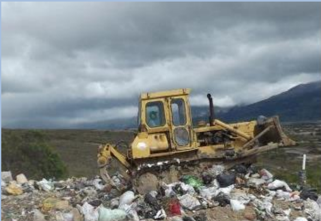
Trabajos de empuje, compactación y cobertura de los desechos sólidos Fecha: 20 de Julio del 2022 (Segunda Plataforma)
