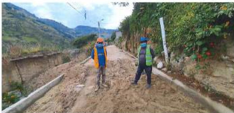
Fotografía 6.- Obreros con casco, chaleco, mascarillas. (2022-10-5)
