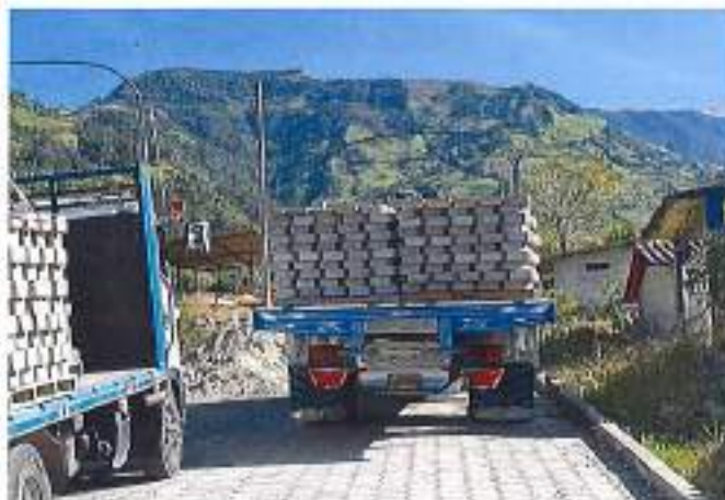
- Fotografía 1.- Material pétreo en obra. (2022-09-27)
