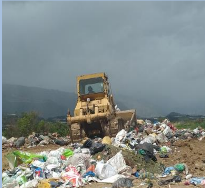
Trabajos de empuje, compactación y cobertura de los desechos sólidos Fecha: 10 de Noviembre del 2022 (Segunda Plataforma)
