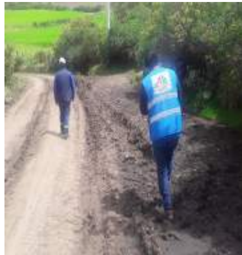
Imagen 6 y 7. Deslizamiento de tierra a causa de las fuertes lluvias en temporada de invierno.
