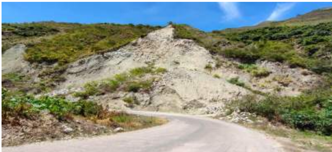
Imagen 7. Deslizamiento de tierra a causa de las fuertes lluvias en temporada de invierno.
