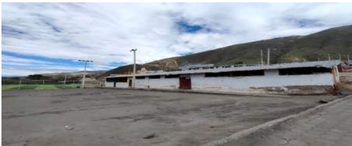
Imagen 17. Centro de la comunidad Caldera, identificación de equipamiento rural. Fuente: Elaboración Propia
