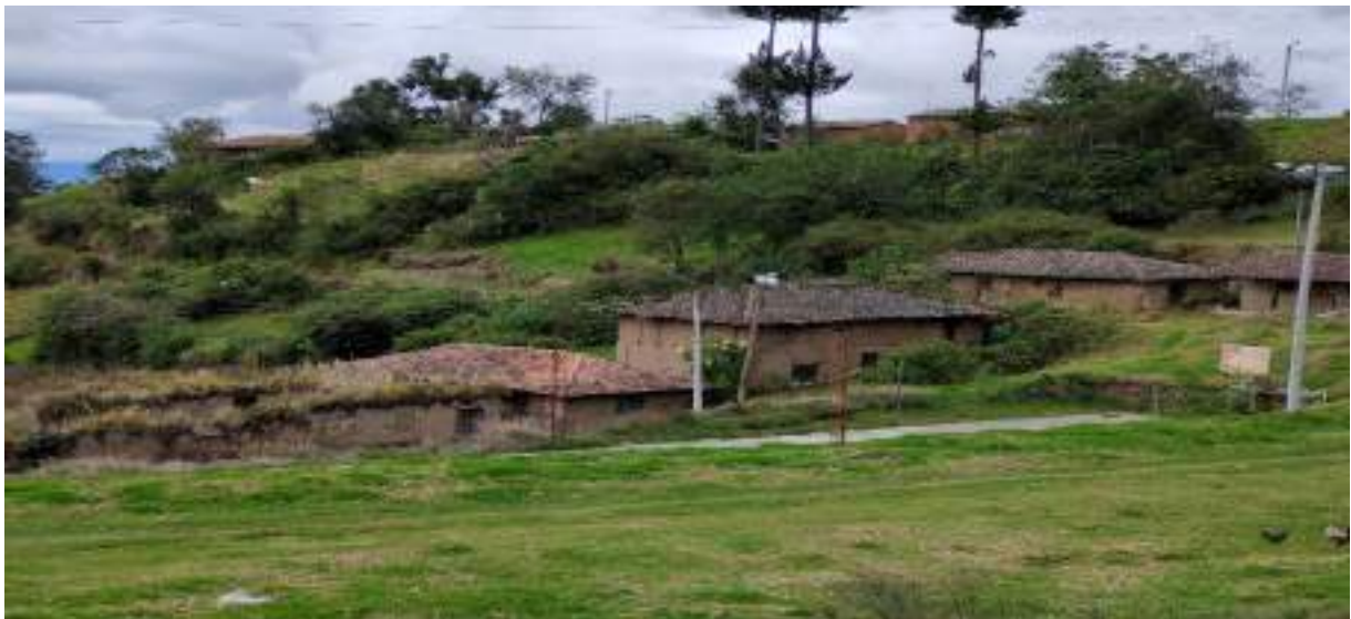
Imagen 11. Viviendas en desuso y deterioro ubicadas en el centro de la comunidad Fuente: Elaboración Propia
