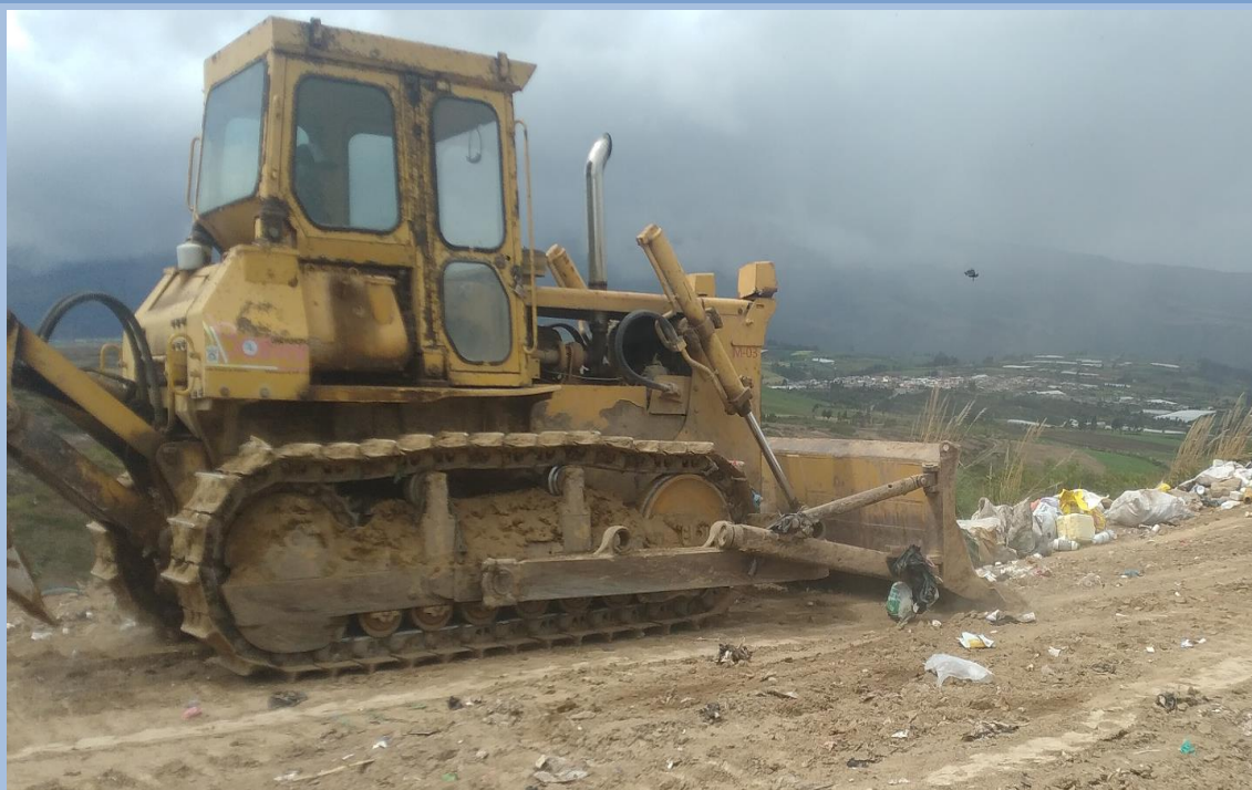
Trabajos de empuje, compactación y cobertura de los desechos sólidos Fecha: 20 de Enero del 2023 (Segunda Plataforma)
