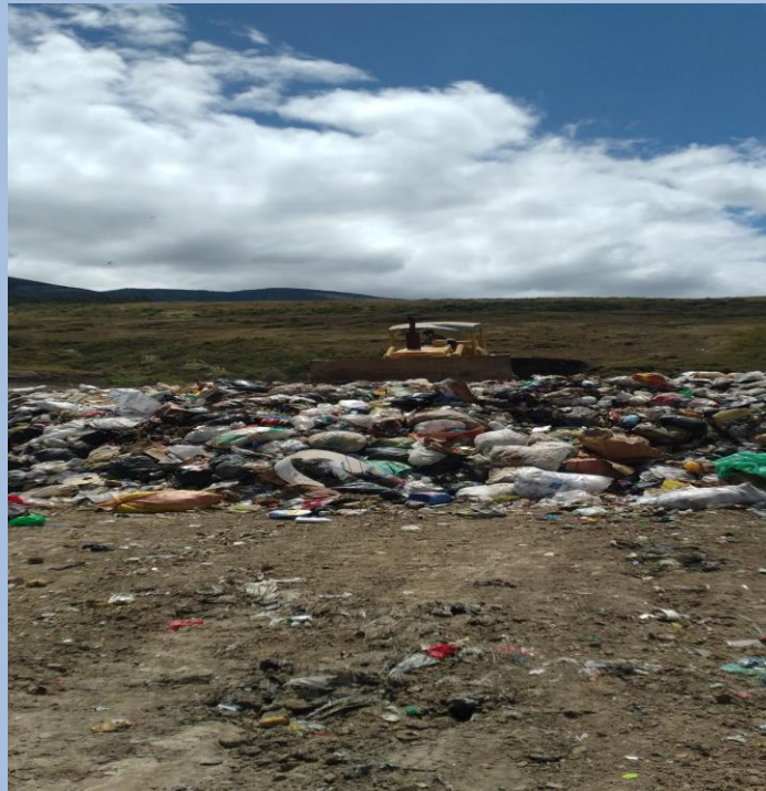
Trabajos de empuje, compactación y cobertura de los desechos sólidos Fecha: 14 de Julio del 2023 (Segunda Plataforma)
