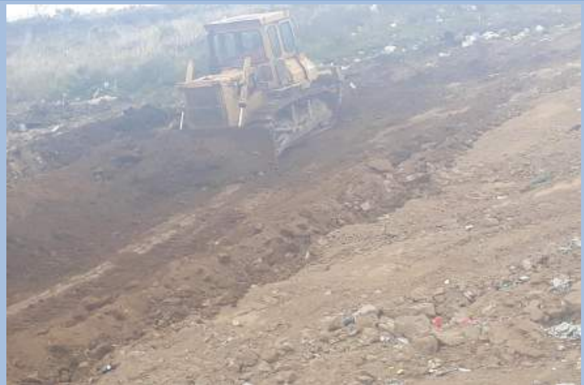
Trabajos de empuje, compactación y cobertura de los desechos sólidos Fecha: 21 de Febrero del 2024 (Segunda Plataforma)
