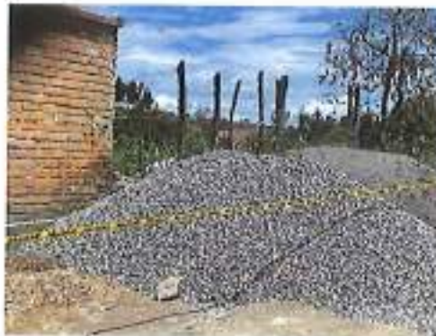
Cinta de seguridad
