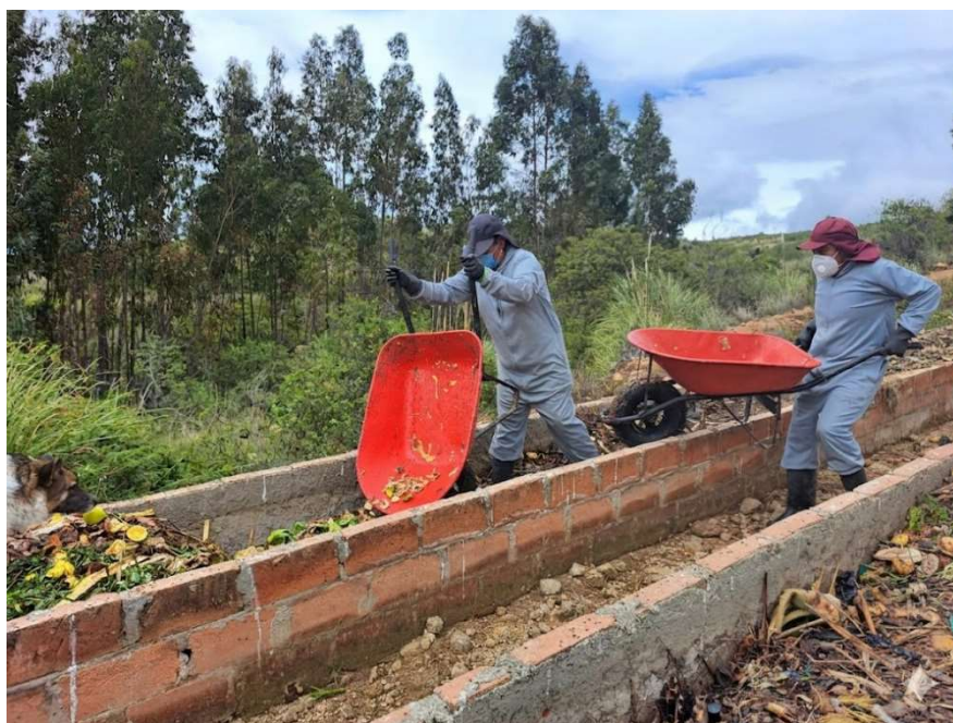
Fotografía 14 Ingreso de material orgánico a las compoteras del relleno sanitario
