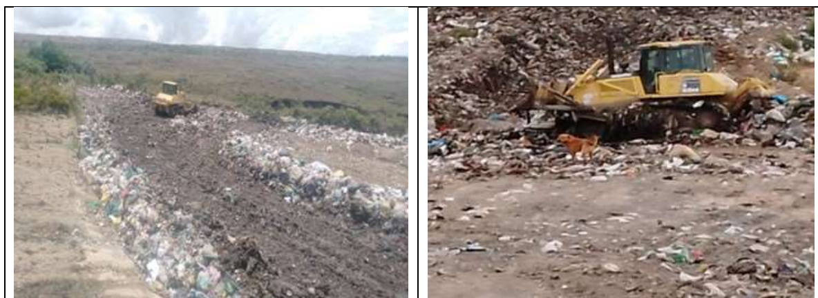
Fotografía 16 Tratamiento de los desechos sólidos no peligrosos (empuje y compactación)
