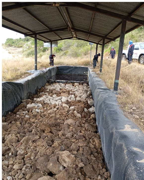
Fotografía 34 Piscina de tratamiento de lixiviados sin descarga
