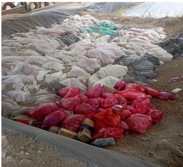
Fotografía 54 Celda especial de tratamiento y disposición final de desechos sanitarios ubicada en el relleno sanitario
