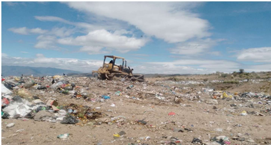
Fotografía 24 Operación mecanizada de la segunda plataforma de confinamiento de los desechos sólidos no peligrosos
