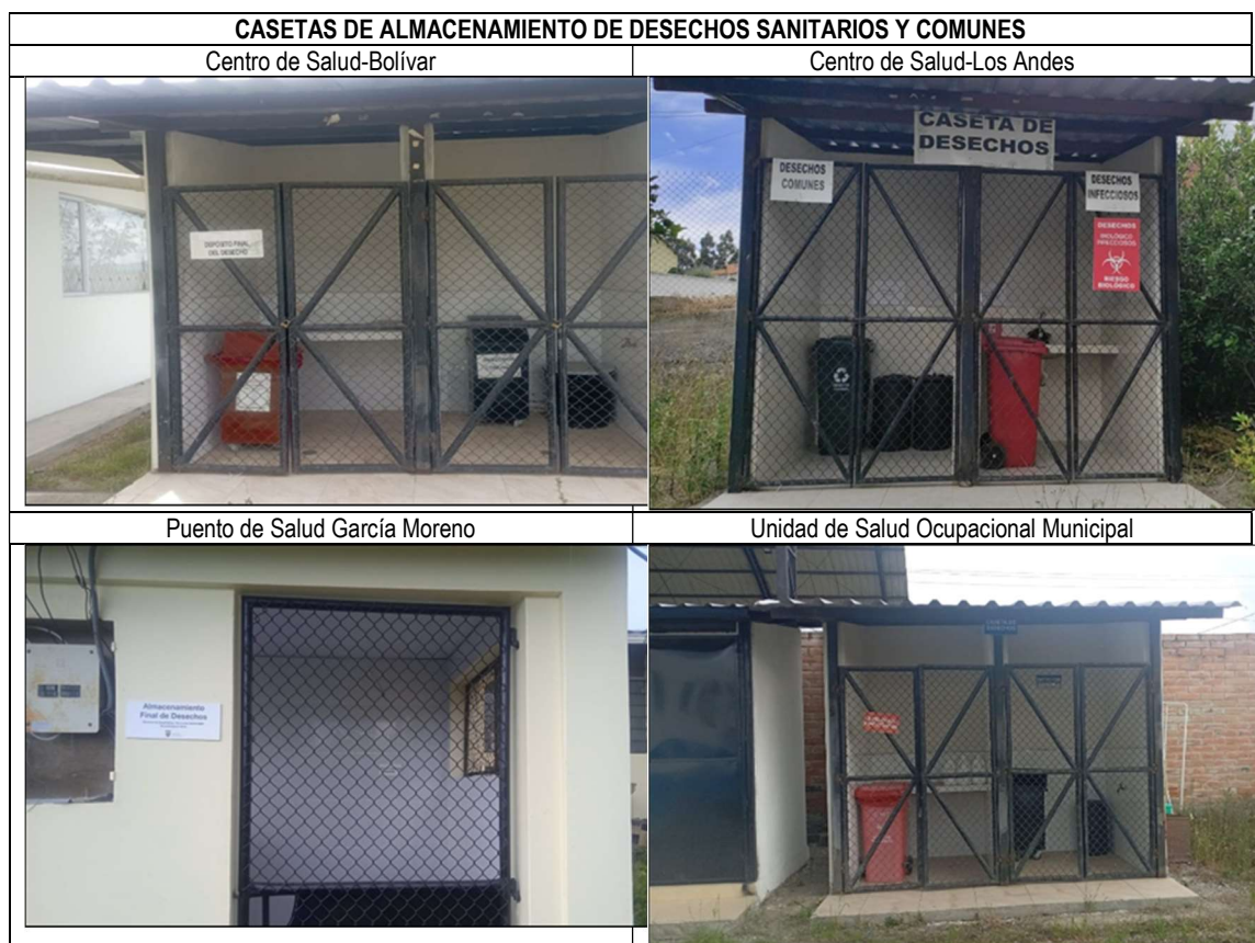
Fotografía 50 Casetas de almacenamiento de desechos sanitarios y comunes
